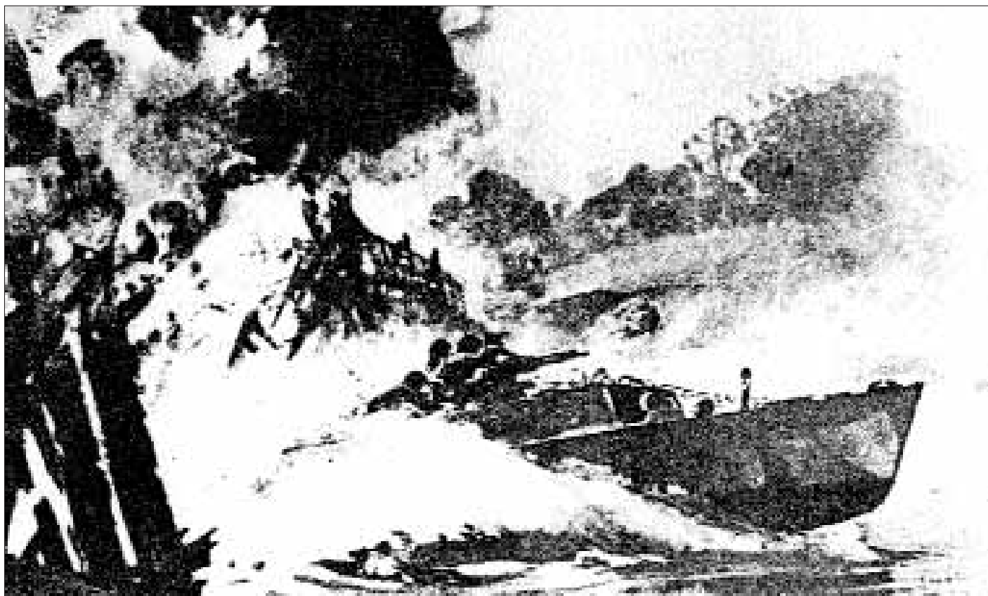
Przeprawa KU-30 w pobliżu mostu w Wyszogrodzie
