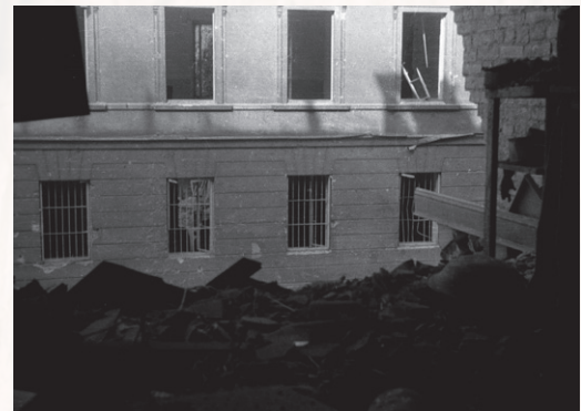
Widok na oficynę pałacu Raczyńskich zza gruzów naprzeciwległego domu przy Kilińskiego 3. Na pierwszym planie zniszczenia po eksplozji niemieckiego nosiciela ładunków wybuchowych. FOT. WIEŚLAW CHRZANOWSKI/ARCHIWUM MUZEUM POWSTANIA WARSZAWSKIEGO
