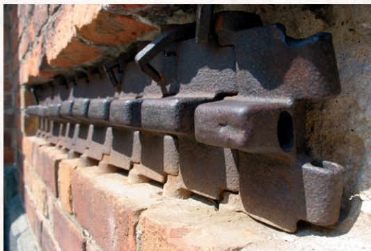
Fragment gąsienicy z czołgu wbudowany w ścianę warszawskiej Katedry FOT. DOMINIK KAZMIERSKI
