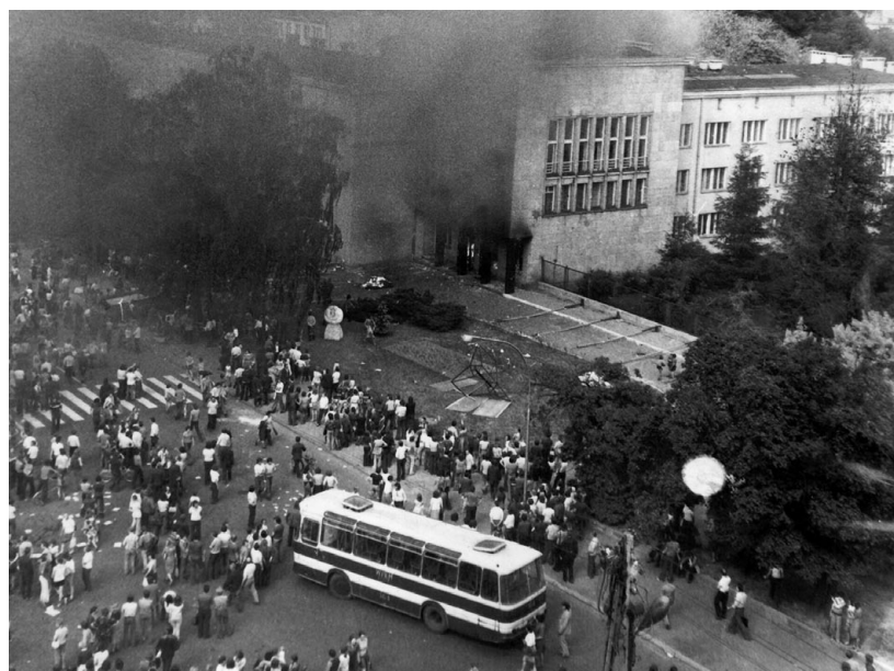
Płonący budynek Domu Partii w Radomiu FOT. EAST NEWS
